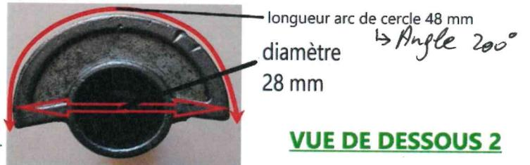
Pièce originale en alliage. Peut être réalisée en acier.
