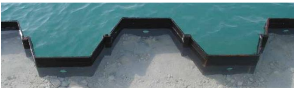
Figure 12 Palplanche stabilisant une digue artificielle
